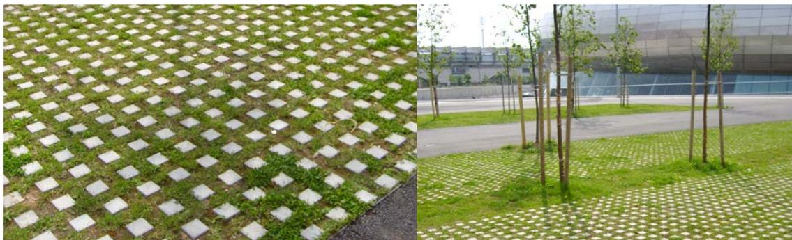
Imagen 03. Pavimento Checkerblock o equivalente.
